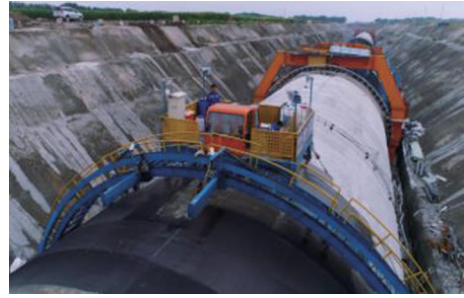
图 5 喷涂机器人现场作业
